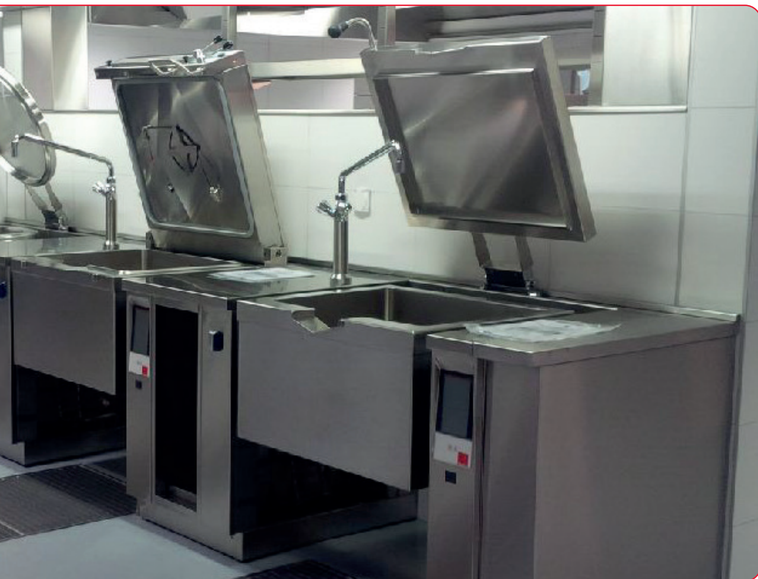
Installation de l'école hôtelière de Genève
